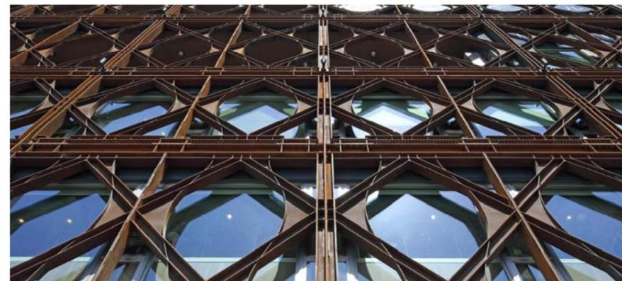
【補強鋼製ファサード】
